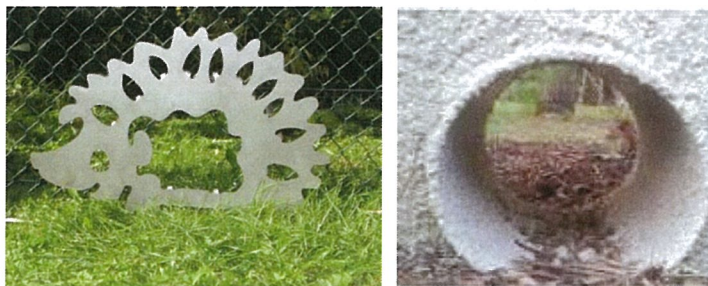
Figure 2 - Exemples d'ouvertures dans un grillage et un muret prévues pour le passage de la petite faune (Source : U2B - Limiter l'impact des clôtures sur la biodiversité, 2014)
