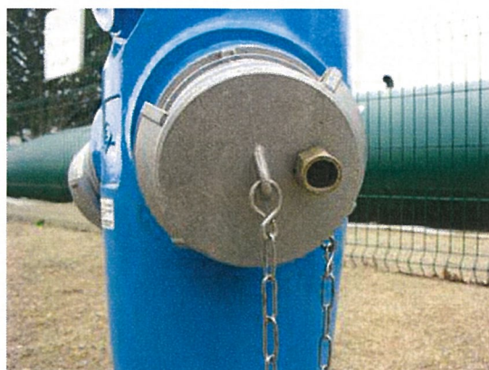
Poteau d'aspiration de 150 mm muni d'un Airclap
