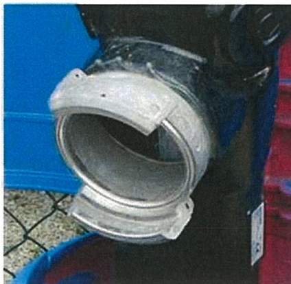
Poteau d'aspiration de 100 mm, muni d'une sortie de 100 mm, avec raccord fixe
