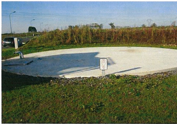
Réserve d'eau enterrée
