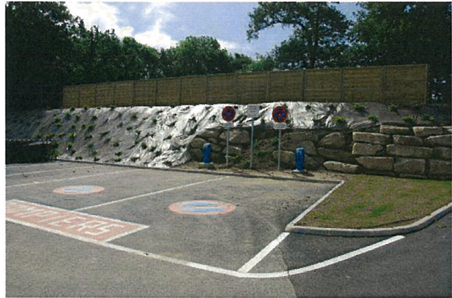
2 Plats formes d'aspiration sur une réserve d'eau équipée de deux poteaux d'aspiration de 150 mm
