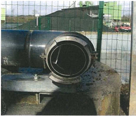
Une sortie de 100 mm avec les tenons verticaux (l'un au dessus de l'autre)
