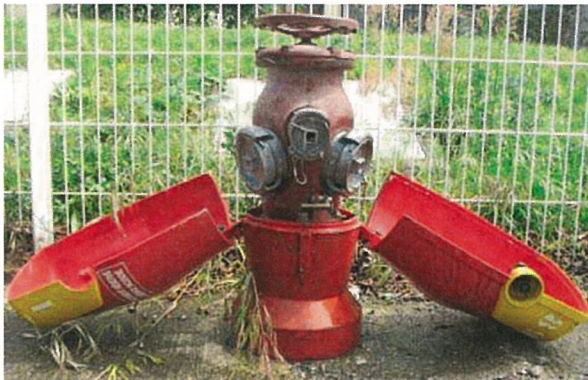
Poteau Incendie de 150 mm avec deux sorties de 100 mm et une sortie de 65 mm
